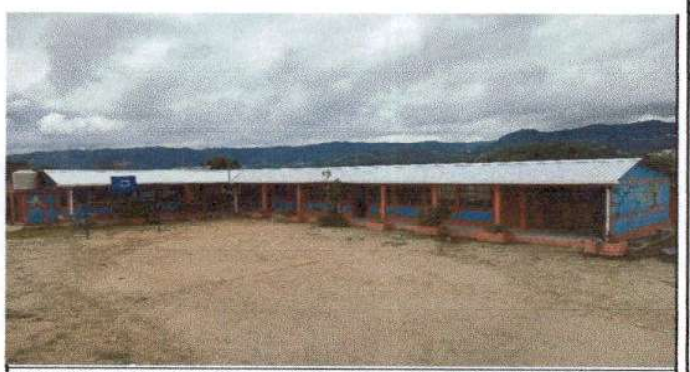
Foto 6: Sustitución de lámina, por lámina troquelada aluzinc calibre 26 y sustitución de bajada de agua pluvial de metal por tubo PVC 3".
