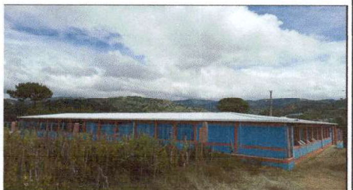
Foto 4: Sustitución de lámina, por lámina troquelada aluzinc calibre 26 y sustitución de bajada de agua pluvial de metal por tubo PVC 3".
