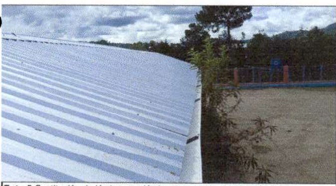
Foto 5: Sustitución de lámina, por lámina troquelada aluzinc calibre 26 y sustitución de bajada de agua pluvial de metal por tubo PVC 3".
